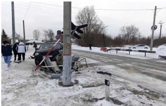
**3 февраля 2025 г. на ж.д. переезде 836 км пк 5 перегона Ирбейская-Коростелёво (Ирбейский район) при следовании через переезд лесовоза «УРАЛ» допущен разрыв стропы увязки груза, в следствие чего в границах переезда 3 бревна, без повреждений устройств ОАО «РЖД» и без сбоя графика движения поездов**
